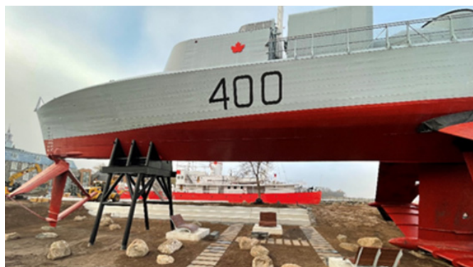
Chantier de l'aménagement de l'Escalier de l'hydroptère APL, octobre 2021- Crédit : Martin Bérubé de Pratte Paysage +
