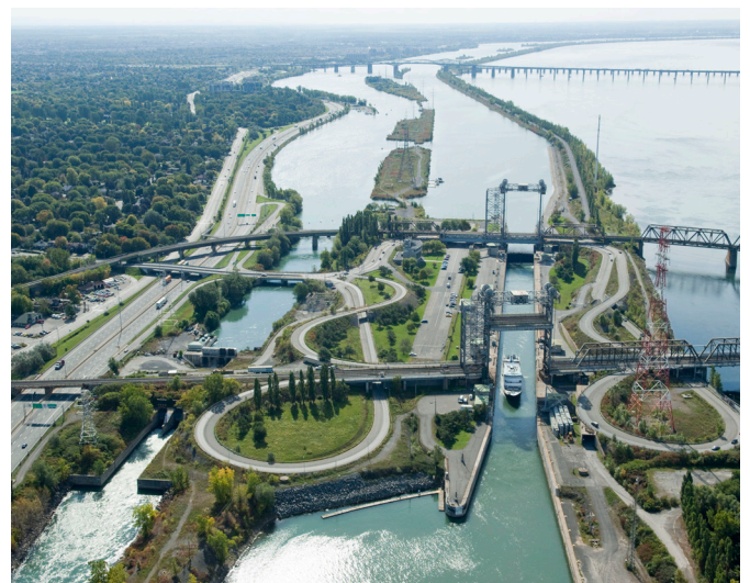
Photo aérienne des installations à St-Lambert
